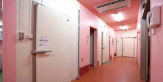
冷凍室・冷蔵室
